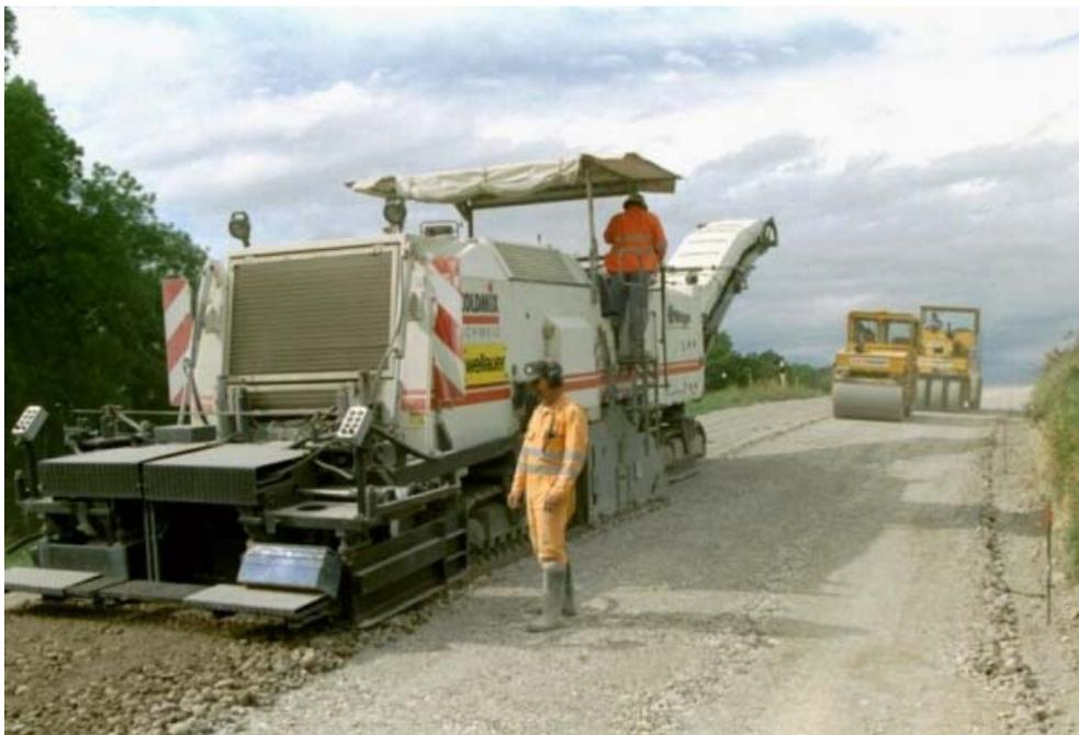
**Abbildung 3: Kaltrecycling-Maschine: Fräsen, Mischen und Einbauen in einem Arbeitsgang, erlaubt 100 %-ige Wiederverwendung des Oberbaumaterials**
