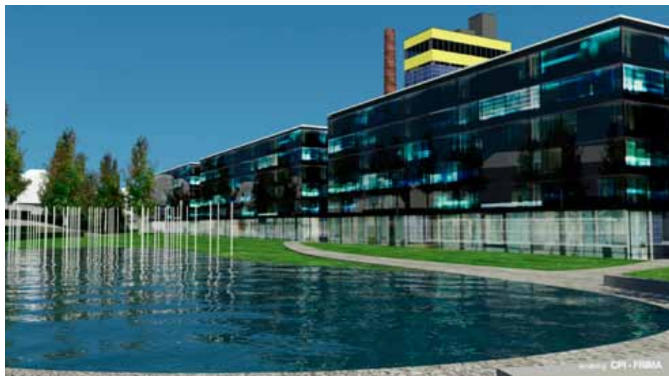
Das Gelände der Blue Factory wird zu einem Technologie-Innovationszentrum ausgebaut. Das SLL wird eine Vielzahl von Institutionen beherbergen und weltweit mit weiteren Kompetenzzentren in Kontakt stehen.
